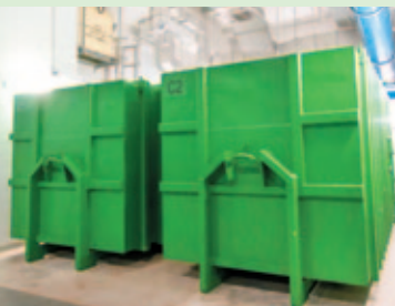
設於地庫的中央廢物收集站 Central refuse collection station in basement
